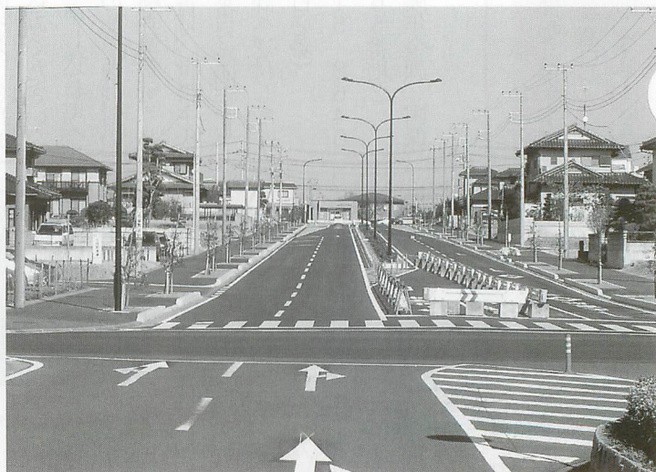
平成17年度に一部開通した駅前・東ノ辻線
