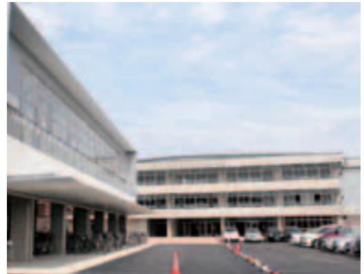
新設された武道館（左）と校舎（右）
