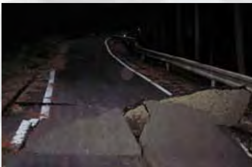
◀地割れにより大きくめくれたアスファルト（根小屋）
