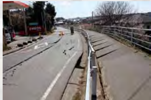
◀亀裂がはしり歩道と車道が大きくゆがんだ県道（高浜）
