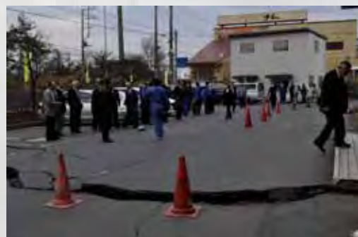
◀陥没して段差ができた駐車場（石岡警察署）
