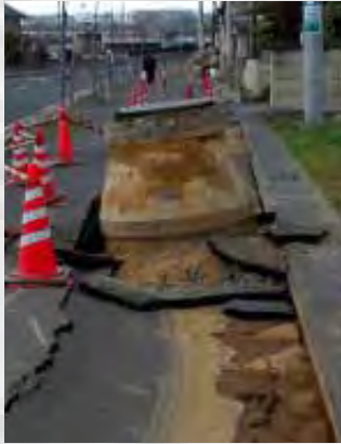
▲液状化で浮き上がった下水道マンホール（石岡一丁目）
