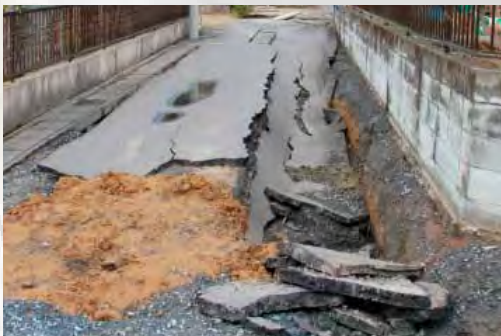
◀大きく陥没した道路（鹿の子）
