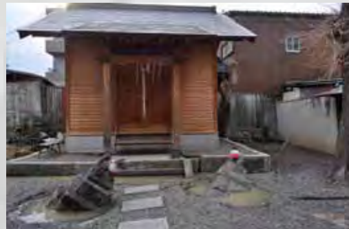
◀液状化現象で沈んだ狐像（開運稲荷神社・国府）
