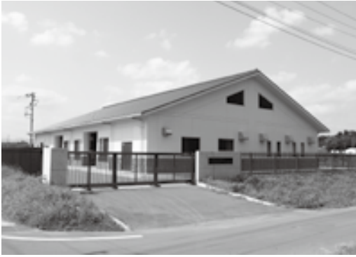
▲西部地区農業集落排水施設
