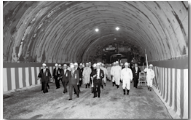
▲平成25年3月開通予定の朝日トンネル
