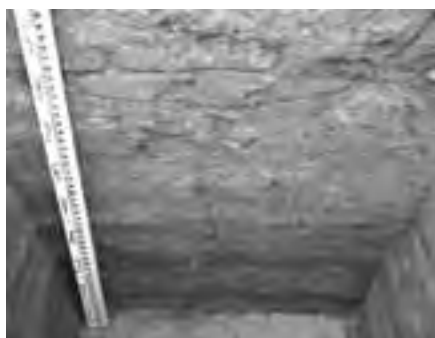
回廊の地盤改良工事の様子
