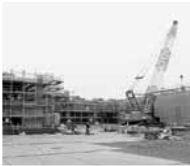
改築工事中の東小学校
