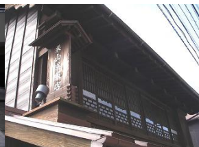
商店街ファサード整備により再生された商店
