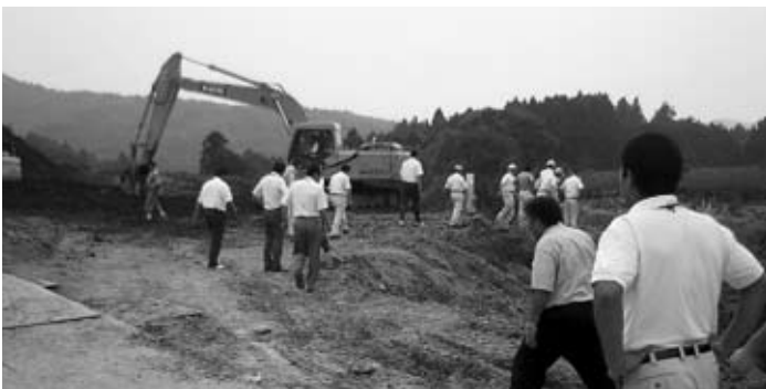
▲川又地区の土砂搬入現場を調査する市職員
