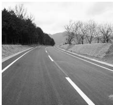
整備が進む八郷中央地区農道
