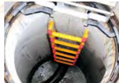
② マンホールの中の下水道管
