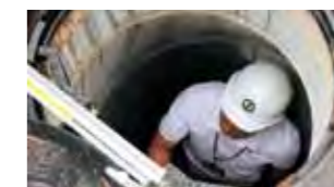
下水道が詰まるなど異常が発生したときは、マンホールの中に入って点検します。
