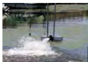
今年度から高浜の舟溜りに設置されたジェットポンプ。これにより、水面に波を立てることで、アオコの停滞を防ぎます。
