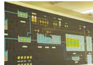
① 管理室で浄水場の状態を常時監視し、緊急時に備えます。
