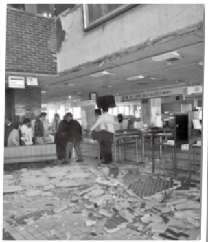
▲被災した本庁舎内部の様子
