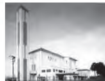
霞台厚生施設組合 環境センター
