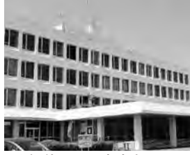
▲解体になる本庁舎
