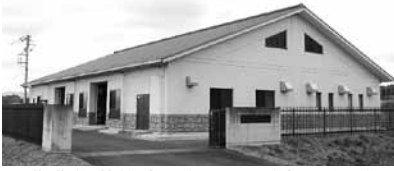
▲農業集落排水の処理場（染谷地区）
