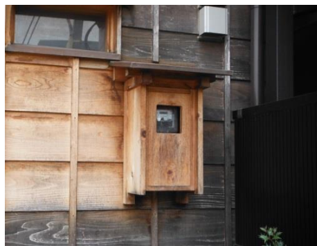
電力メーターを木製の箱に入れた事例 (川越市)
