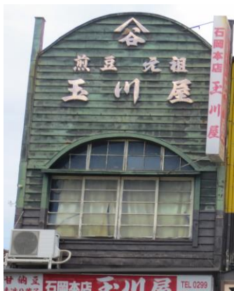
ファサードの形状に合わせた窓形状（看板建築）
