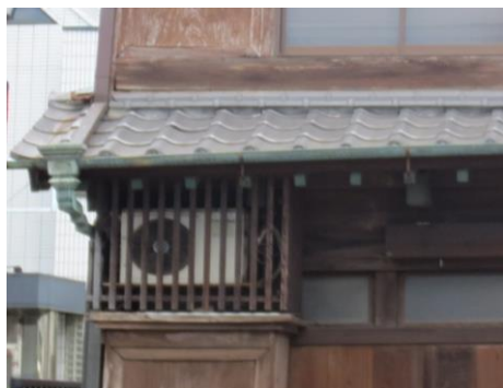
エアコンの室外機を木製格子で囲った事例
