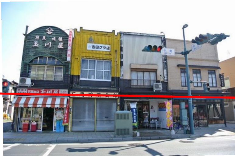
開口部を工夫し、軒線の連続性に配慮
