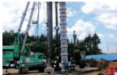
▲杭は固い地盤（支持層）まで打ち込むため長さが約 38m にもなります。
