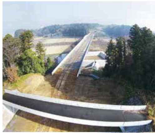
▲東田中地区の改良工事の様子
