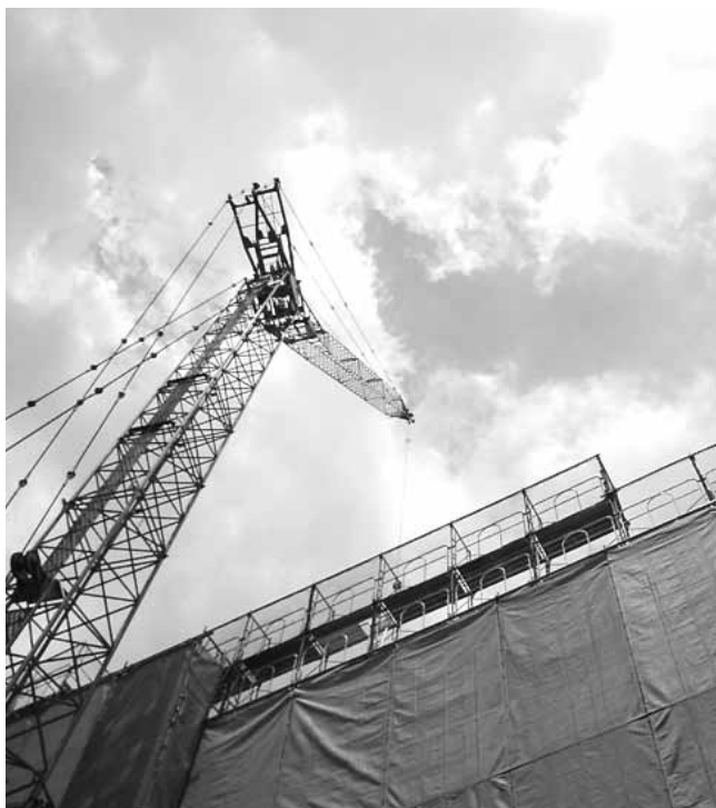
▲平成31年1月開庁予定の新庁舎の建設工事が進行中です
