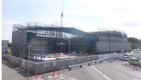
工事が進む新庁舎建設事業
