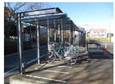
東田中駅屋根つき駐輪場
