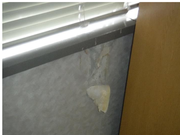
集会室クロスの亀裂
