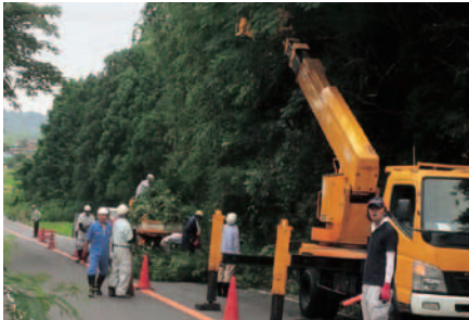
▲技術が必要な高所作業車のオペレーターは業 者に、交通整理などは市職員が担当しました
