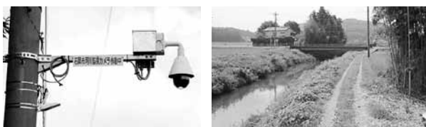
▲電柱に共架した河川監視カメラ（監視カメラからの見え方）
