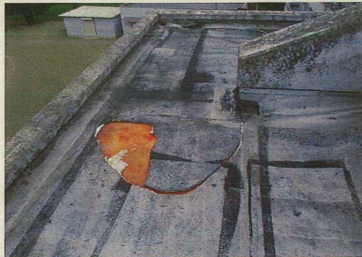
クランク部西方向
