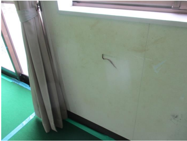
汚れた集会室の壁
