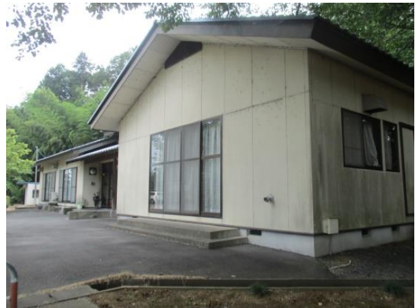
外壁には黒墨や剥がれた箇所が目立つ
