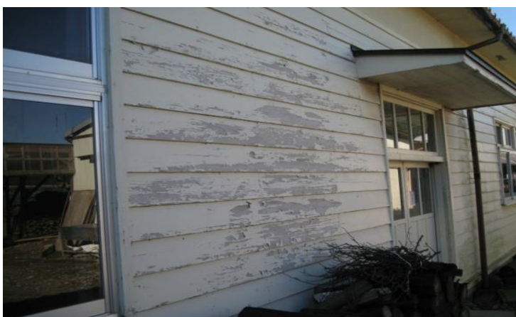
外壁の塗装の剥離 (平成29年度に改修済み)
