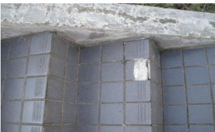
階段タイルの剥離
