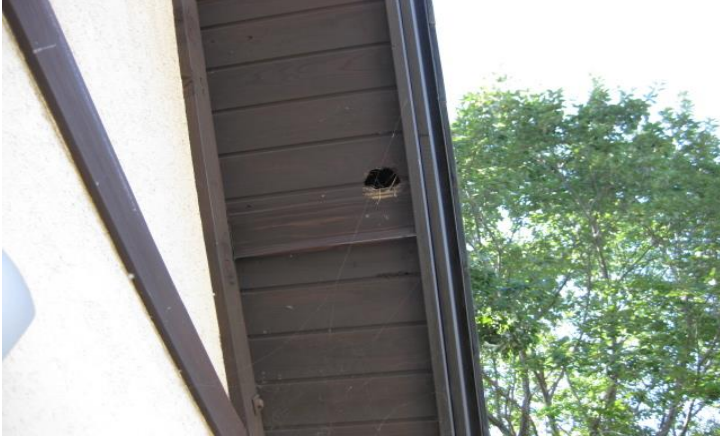
屋根材の損傷
