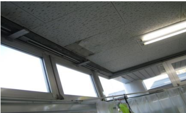
外部からの漏水による損傷
