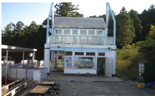
管理棟・浄化施設
