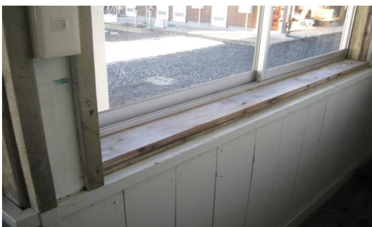
窓枠からの漏水
