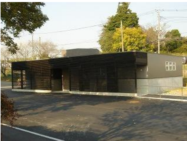
駐車場トイレ
