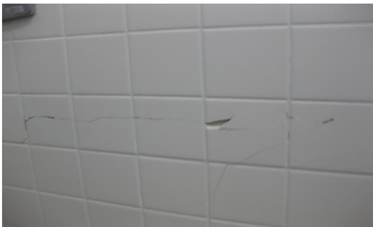
壁，タイルのひび割れ
