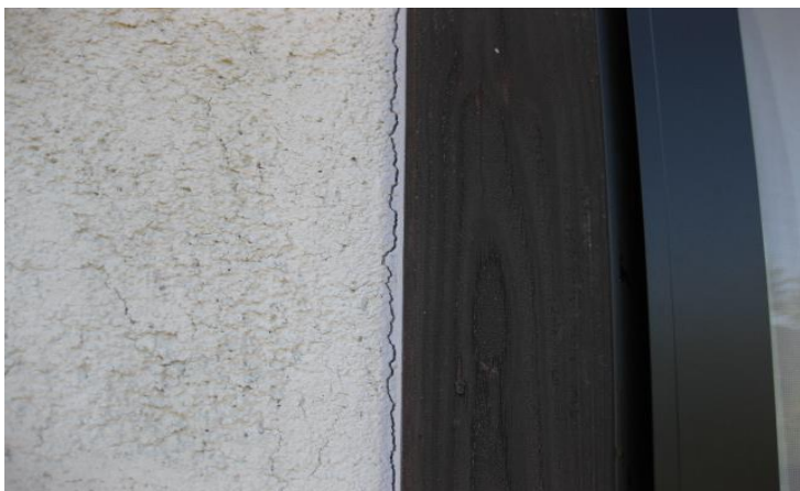
外壁の亀裂 (平成29年度に改修済み)
