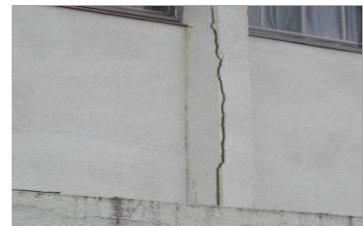
部位名称 体育館・正面玄関上部 大きくクラックが入っている。
