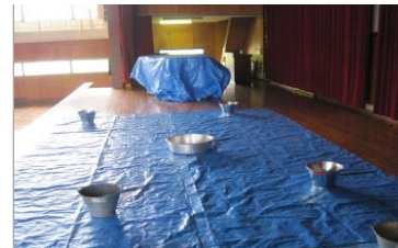
部位名称 体育館・ステージ ステージ上部からの雨漏りのため、常時ブルーシートを敷き詰め、雨漏り箇所にバケツやタライを置いている。
