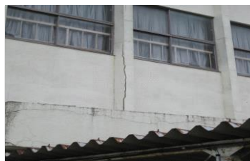
部位名称 体育館・正面玄関上部 大きくクラックが入っていて、表面がはがれ落ちそうである。
