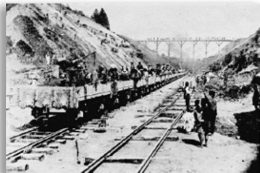
▲高浜駅北側(石岡駅方面)の工事(「石岡の歴史」より) 駅北側はトンネルを掘る計画だったが、恋瀬川付近の湿地に土砂を投入するため、現在のような切通しに変更したという。
