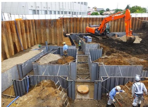
【②型枠工事】基礎コンクリートを打設する箇所に型枠を設置していきます。丸く見えるのは、杭の頭です。
