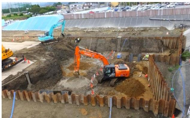
【①掘削工事】新庁舎の基礎工事のため、地下部分を約4m掘削していきます。（土が崩れないように周りを矢板で囲っています）
