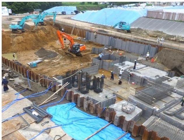
【④鉄筋工事】基礎となる型枠部分に鉄筋を配置していきます。（奥の工区では、掘削・型枠工事を行っています）
