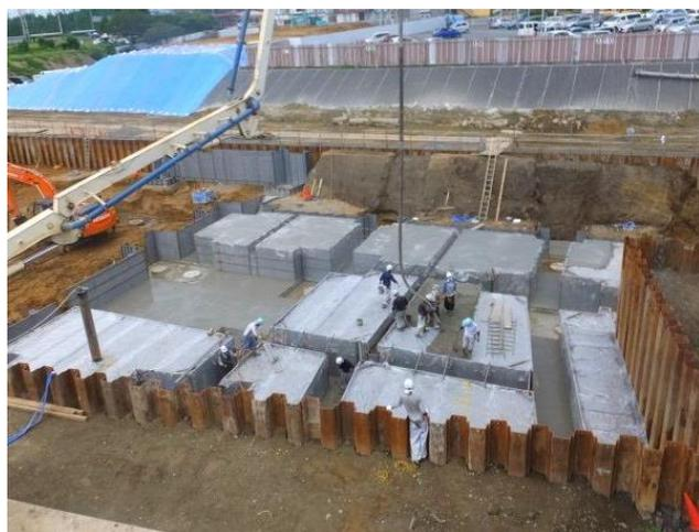
【③捨てコン打設】捨てコンクリートは、鉄筋工事の位置を明示するため、コンクリートを打設するものです。
