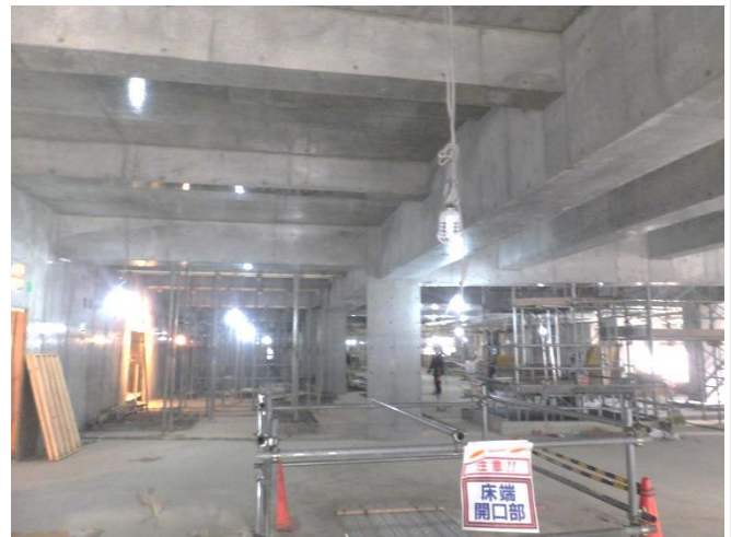
(支保工撤去後)
