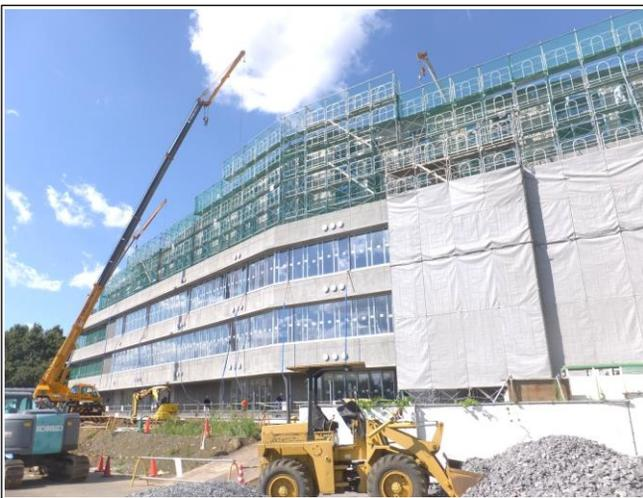
【庁舎南側】南側では外部足場の撤去が始まり、庁舎の外壁やガラス窓が見えてきました。コンクリート部分には、表面保護のための塗装が施されています。
