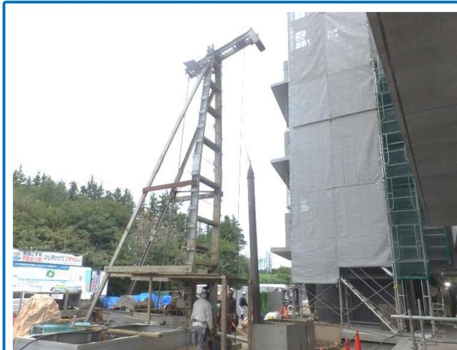
【さく井工事】井戸水を利用するため、さく井機による掘削工事を行っています。
