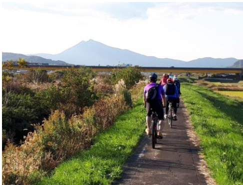
恋瀬川橋梁道路上より道路軸を見る。筑波山等山並みを背景に田園空間を走る。
