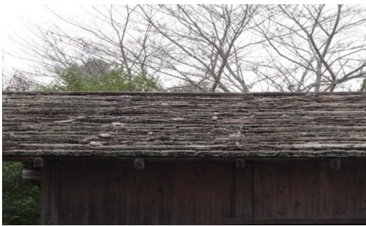
写真3 古代家屋(倉庫)の屋根損傷
