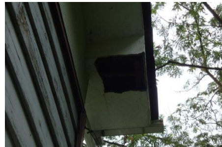
写真12 軒下の破損
