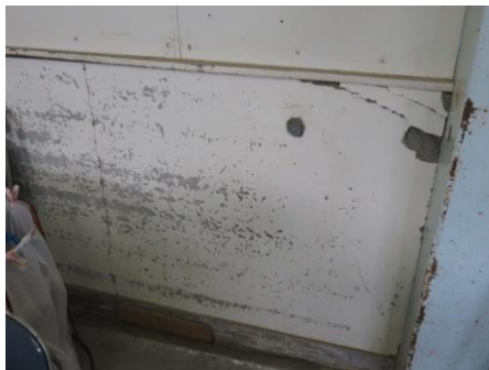
写真 23 1階作業場の腰壁の亀裂
