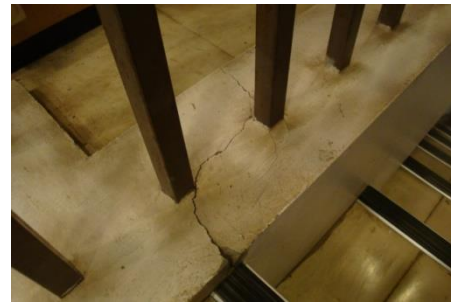
写真8 二階階段付近の亀裂
