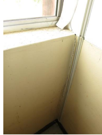
写真 18 刊行物保管部屋の亀裂
