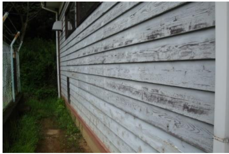
写真9 外壁側面の塗装の劣化
