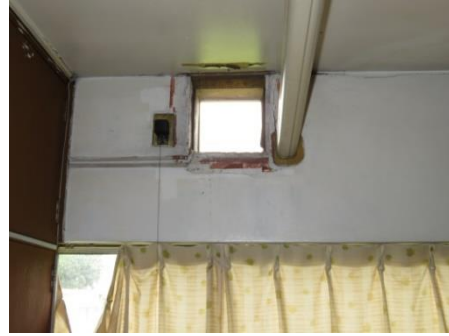
写真 16 刊行物保管部屋のファンの欠落
