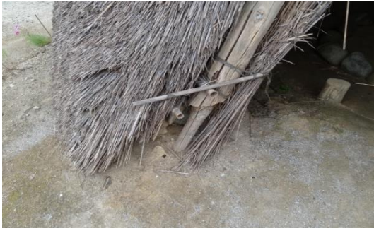
写真1 古代建物(縄文2)の屋根損傷
