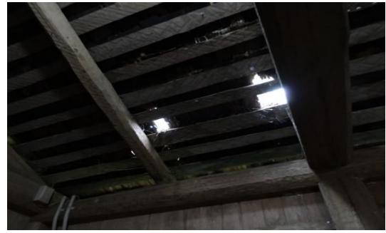
写真2 古代家屋(作業所)の屋根損傷
