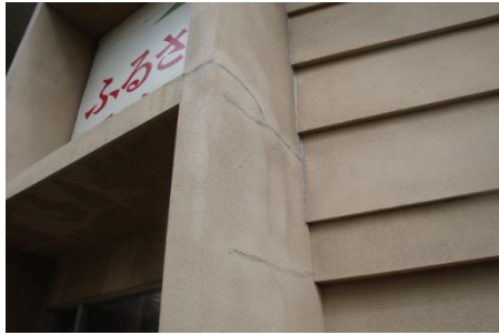
写真5 正面(南側)入口外壁の亀裂
