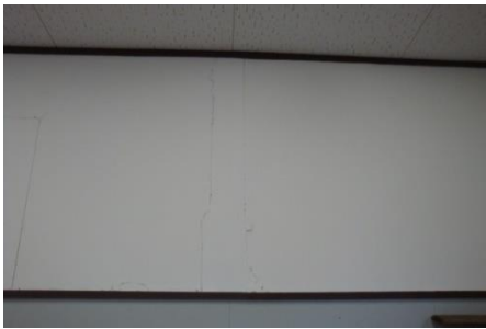
写真11 内壁の亀裂
