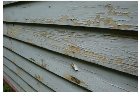
写真10 外壁側面の塗装の劣化
