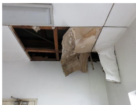
写真14 出入口内部の天井の欠落
