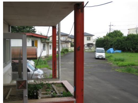
写真 24 鉄鋼柱の塗装の劣化
