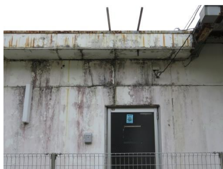
写真13 出入口上部の外壁
