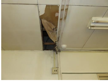
写真 15 刊行物保管部屋の天井板の欠落
