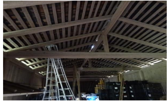
写真4 古代家屋(倉庫)の屋根損傷
