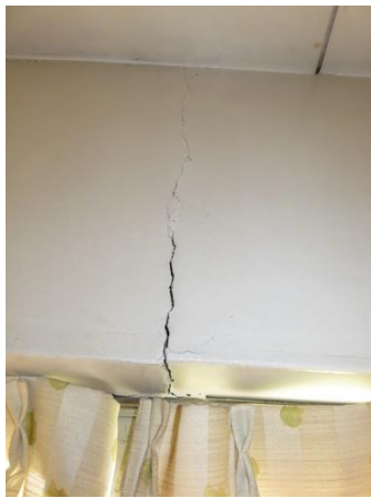
写真 17 刊行物保管部屋の亀裂
