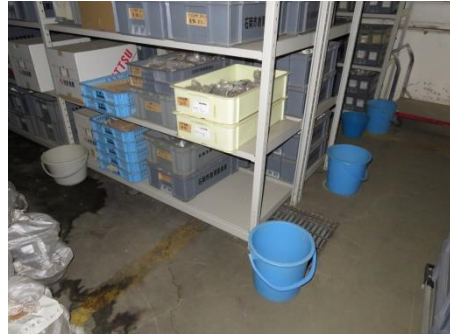
写真 22 雨漏り箇所への対応状況
