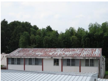
写真 19 2階部分の屋根
