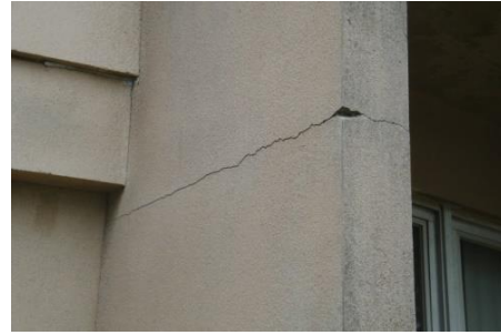
写真6 裏面(北側)外壁の亀裂
