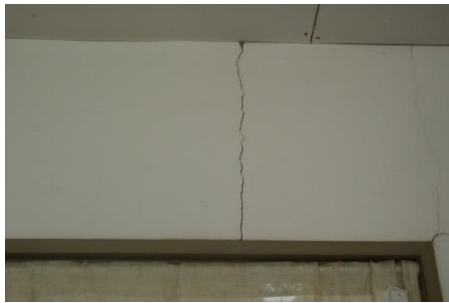
写真7 給湯室の亀裂
