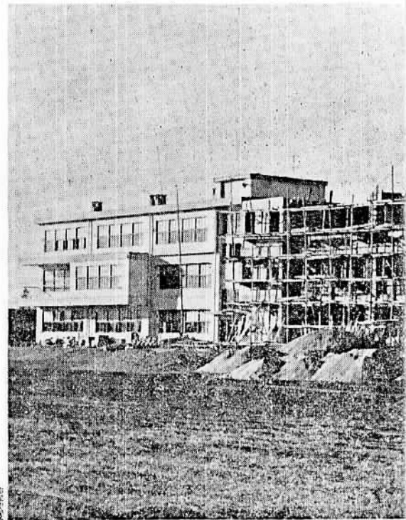
↑ 第一期工事完成、第二
