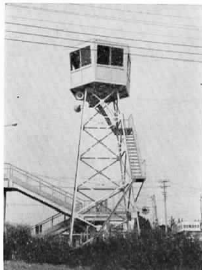
写真は完成した交通監視塔
