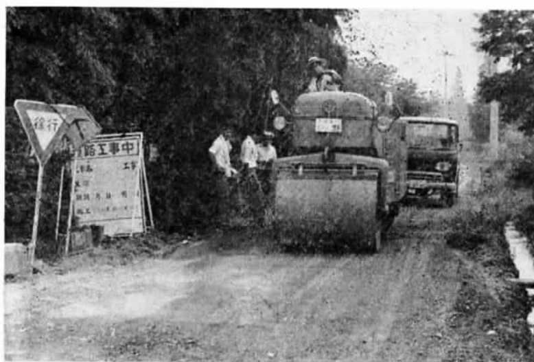
写真は東小学校前～東大橋十字路線の舗装工事
