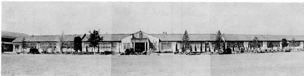
昭和28年に建設されたこの校舎も近代的な校舎に建て替えられ、来年度には取りこわされます。
