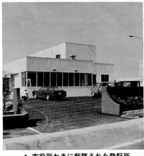
▲市役所わきに新築された登記所
