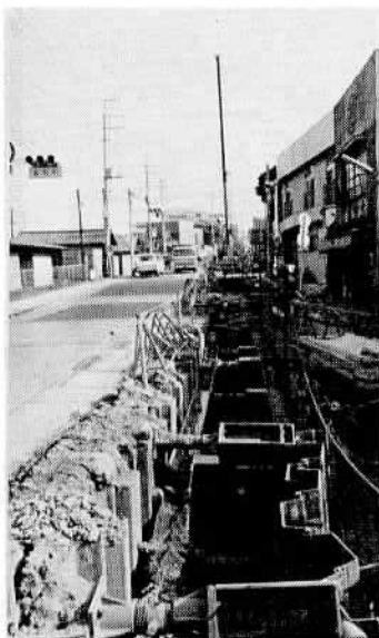
急ピッチで進む管きよ埋設工事すでに4,000mの工事を完了
