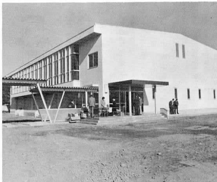
さる12月6日竣工式が行われた杉並小屋内運動場
