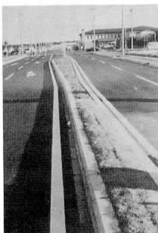
都市計画街路(村上・六軒線)の整備進む
