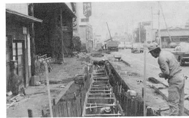
下水道管きよ埋設工事が急ピッチで進められています
