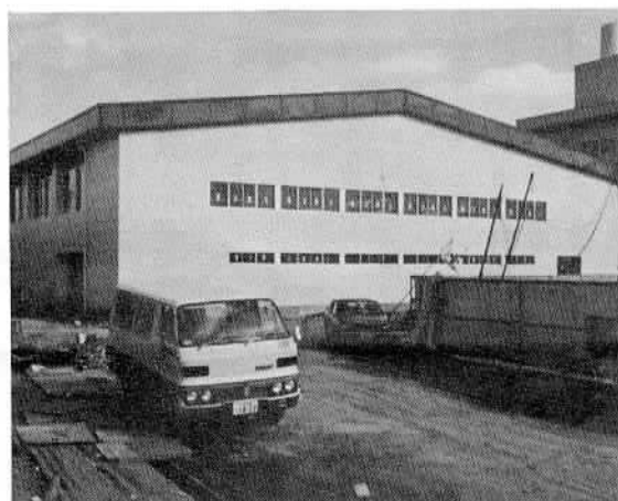
完成間近かの石岡中学校屋内運動場兼柔剣道場
