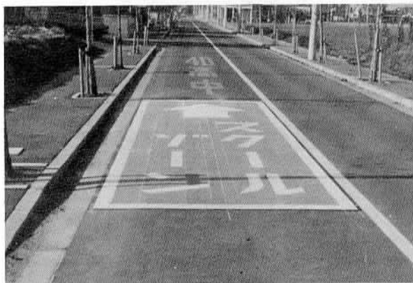
通学道路の路面標示工事が完成
