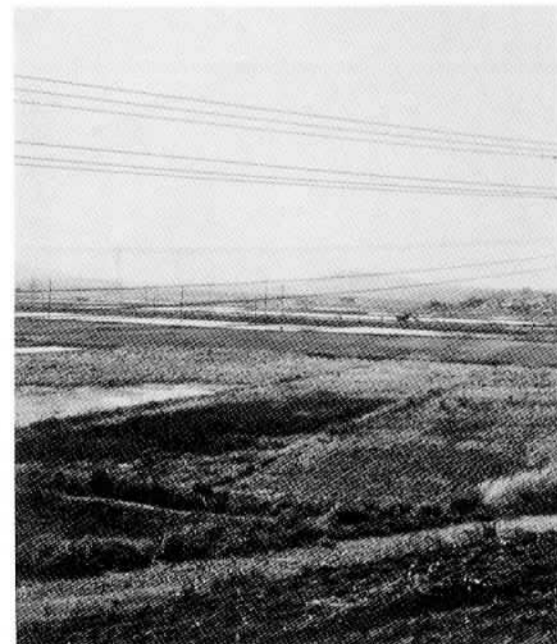
国府中学校用地、造成工事も始まり、年度後期には校舎建設が予定されております。
