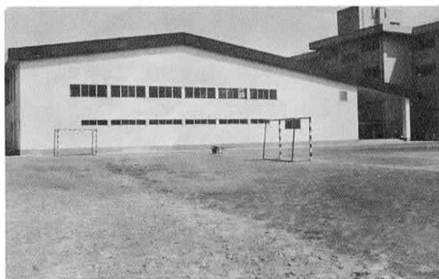
石岡中学校屋内運動場兼柔剣道場 (簡保資金融資施設)
