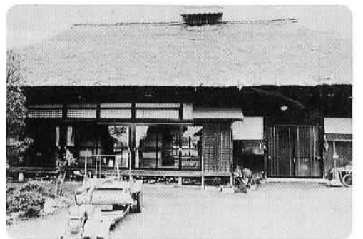
石岡の民家 19 長谷川光雄宅 (梁谷)
