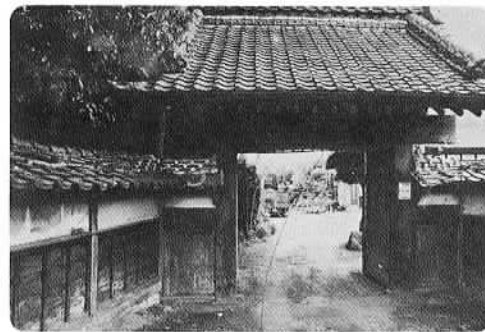
石岡の民家20 鈴木効宅（半の木）
