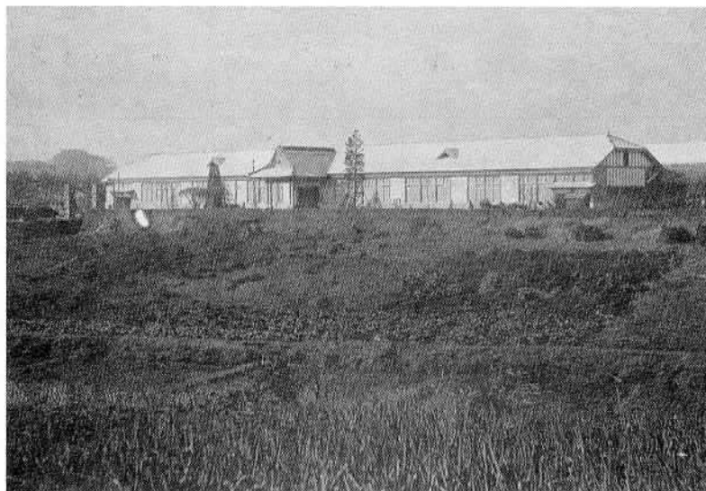
▲現在の消防署近くの高台から眺めた石岡農学校の校舎。手前の田んぼは埋め立てられて記念農園になっている辺りです。
