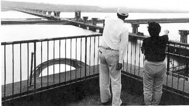
▲洪水と塩害防止のため、昭和38年に完成した常陸川水門
