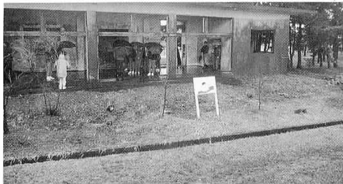
▲昭和40年代半ばまで、多くの遊泳客が利用した浮島休憩所の跡
