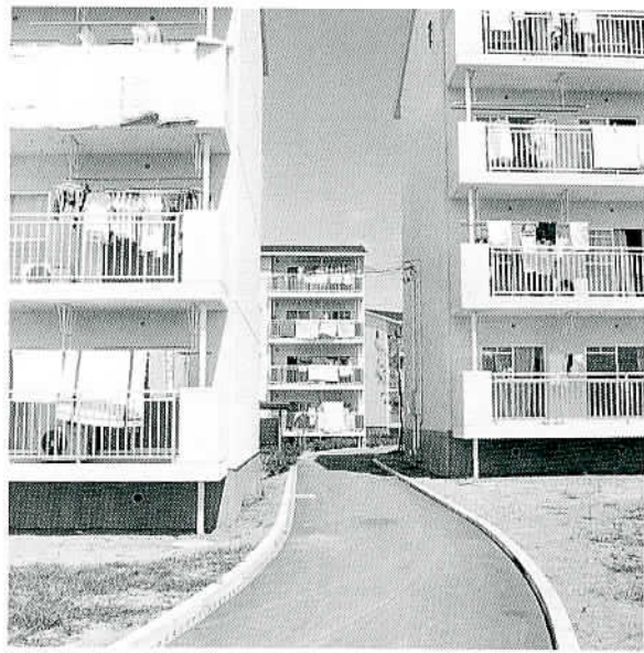
▲建設が進む池の台団地(姥橋)
