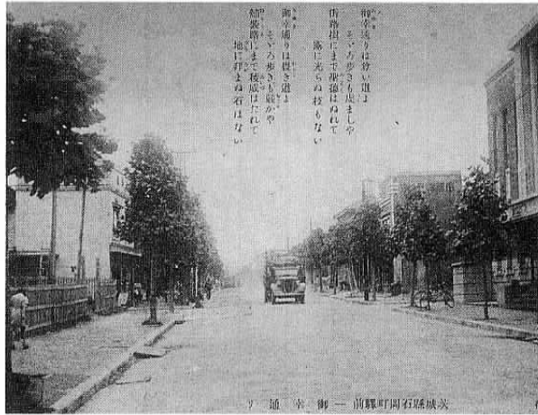
昭和五年に開通した御幸通り。
