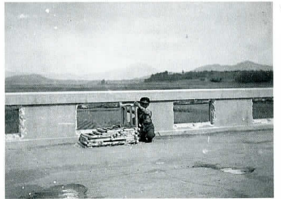
▲国への金属供出のため、鉄柵を外した恋瀬橋。
